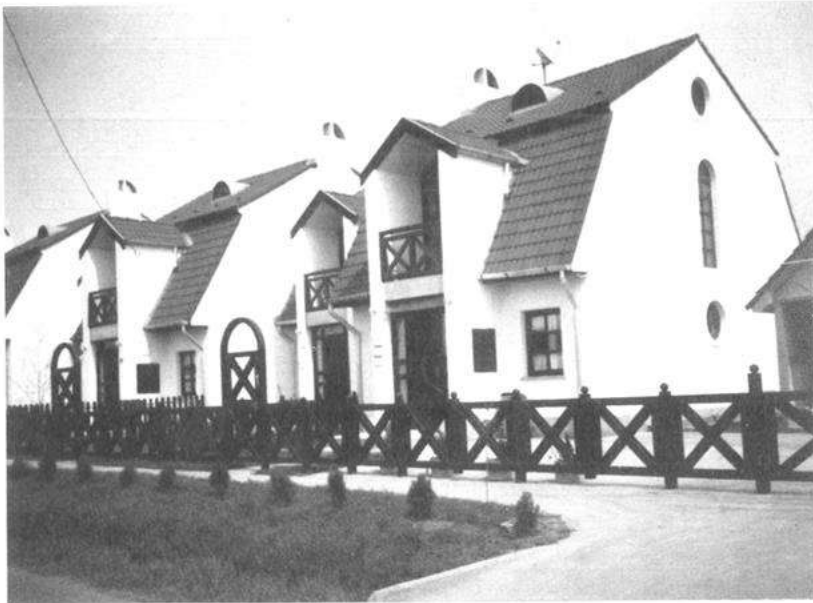
Pásztó, Sorházak (1987-90.), Tóth Tibor építész-mérnökkel Pásztó. Row Houses (1987-90). with Tóth, Tibor architect
