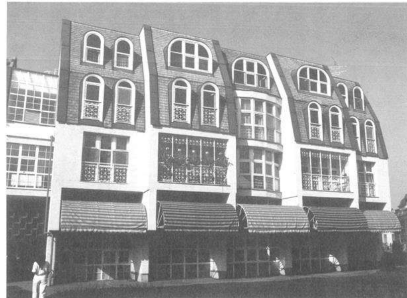
Baja, Városközpont I-II. ütem (1986-90) Nánay Éva és Specker Attila építész-mérnökkel Baja, Town Centre step I-II (1986-90), with Nánay, Éva and Specker, Attila architects
